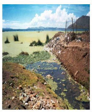
Existe un serio problema de operación relacionado con el sistema de recolección de las aguas pluviales, puesto que dicho sistema se encuentra conectado a la red de alcantarillado en diferentes puntos y en la medida que el sistema de alcantarillado se colmata por el arrojo de residuos sólidos en la red pluvial, provoca que se generen aniegos de aguas servidas en la temporada de lluvias.
